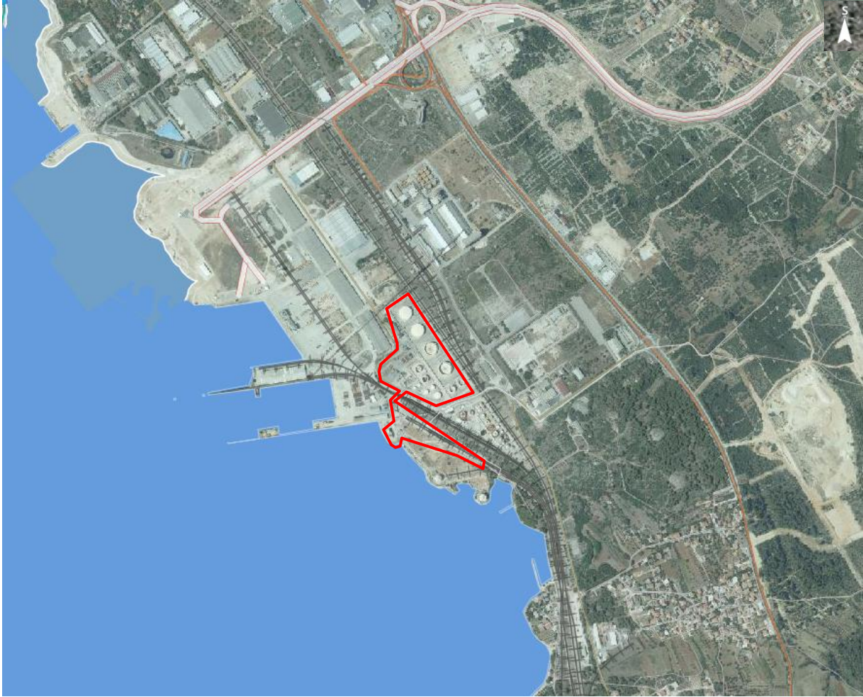
Slika 26. Površinske vode u okruženju područja postrojenja TND
