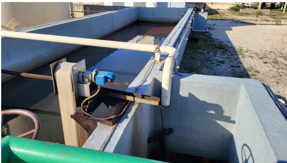
Slika 39. API separator
